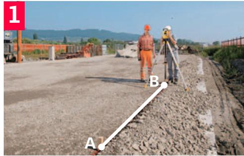
1 Stellen Sie das Instrument über Punkt B auf und horizontieren Sie es.
